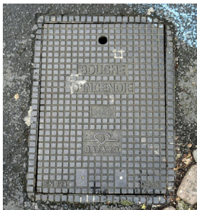
Trappe de borne incendie - Cette typologie peut nécessiter la mise en place d'un dispositif en Y ou T pour laisser un raccordement de protection incendie libre
