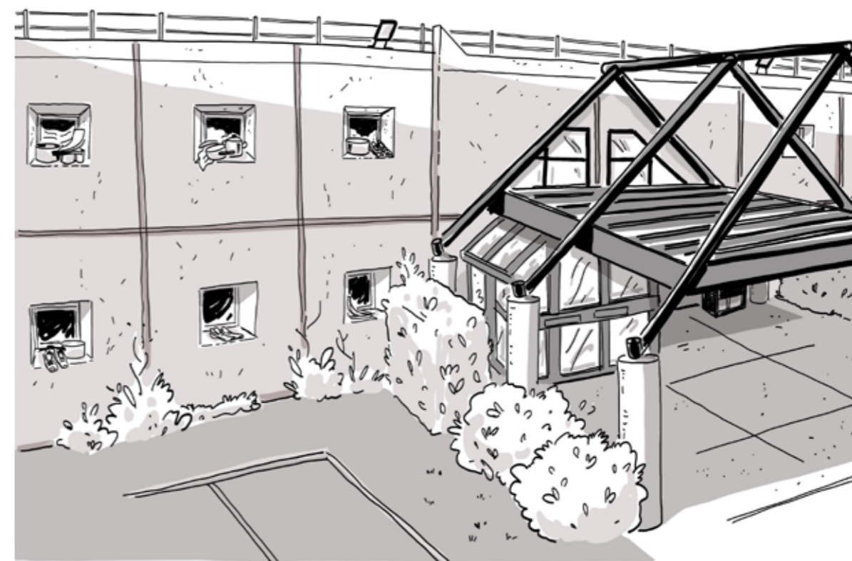
Les PRAHDA sont généralement situés en dehors des villes, dans des zones autoroutières. En l'absence de place suffisante dans les chambres, casseroles, linges, etc. sont posés sur les rebords des fenêtres.
